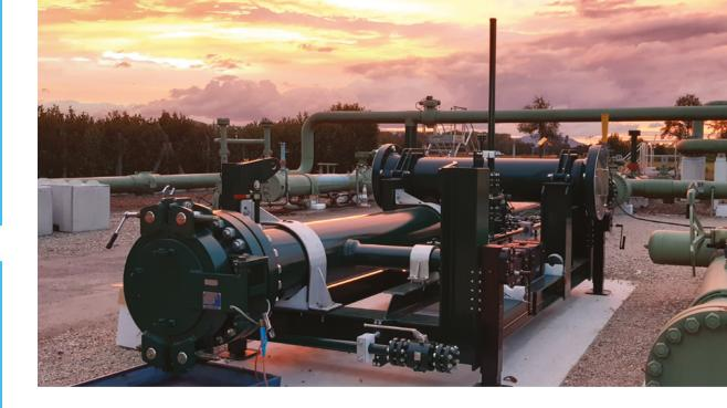
Porté par les opérateurs de réseaux gaz Creos (Allemagne) et GRTgaz (France) en coopération avec le groupe énergétique Encevo (Luxembourg), le projet mosaHYc (Moselle Sarre Hydrogène Conversion) vise à établir un réseau transfrontalier de 94 km de canalisations d'hydrogène dont 70 km proviendront d'une conversion de canalisation de gaz naturel. Il s'agit d'un premier écosystème territorial d'hydrogène transnational au cœur de l'Europe opérationnel dès 2027.
